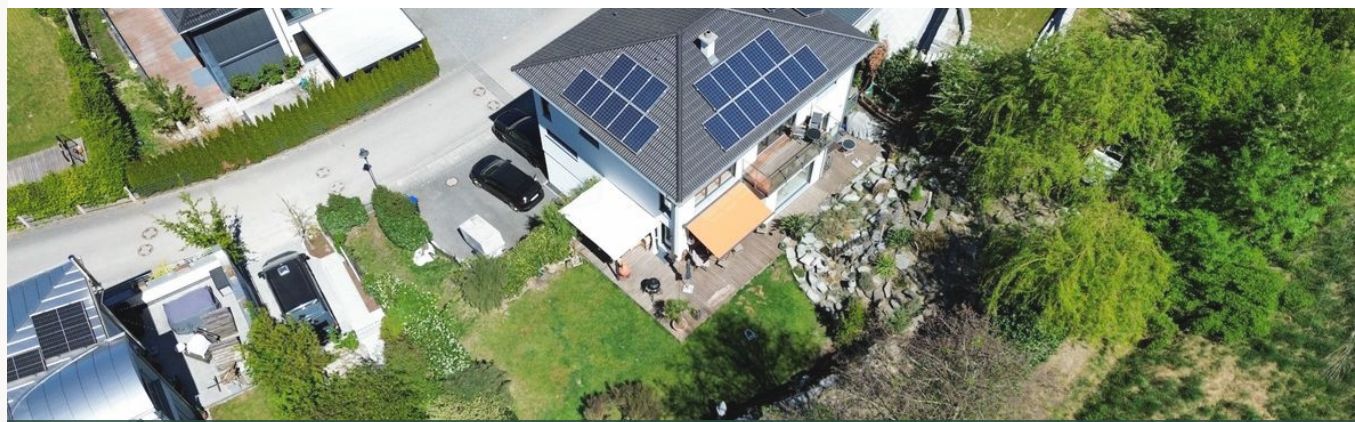
7,14-kWp-PV-Anlage (18 Module) auf dem Walmdach – Drohne
